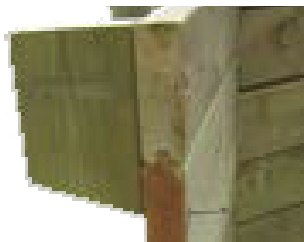
Zarovnejte dřevěný blok s horní částí desky.
