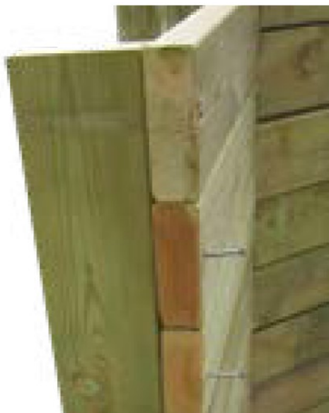
Namontujte výztuhy pomocí 1 šroubovací desky
